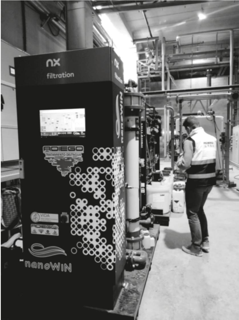
Figura 5. Planta de tratamiento de nanofiltración, NANOWIN.
